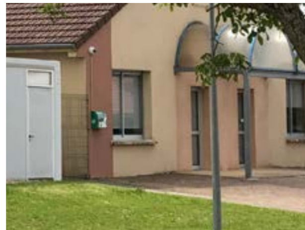
Défibrillateur installé sur le mur du Centre de Loisir et de Rencontre Saint Exupéry
