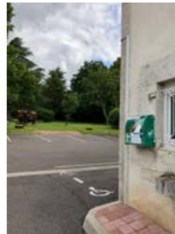
Défibrillateur installé sur le mur de la Mairie
