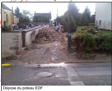
Dépose du poteau EDF
